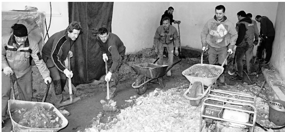
Náročné rozbíjení a vyvážení betonové podlahy během brigády 9. března 2019.
