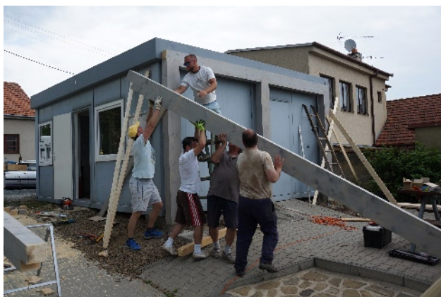
Stavba přístřešku u hřiště, 1. červen 2019
