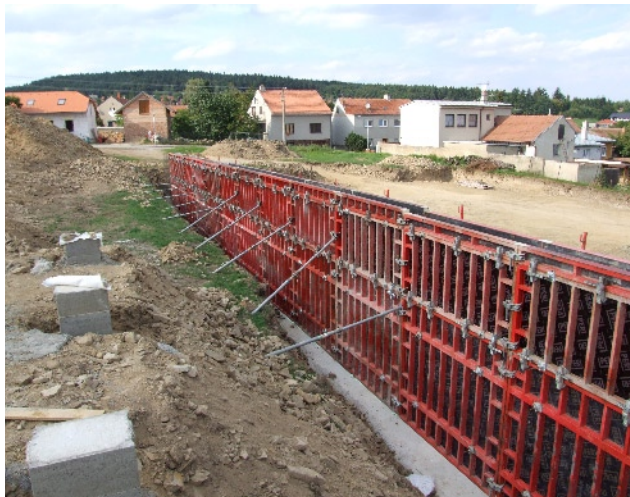
Výstavba víceúčelového hřiště s umělým povrchem, rok 2011
